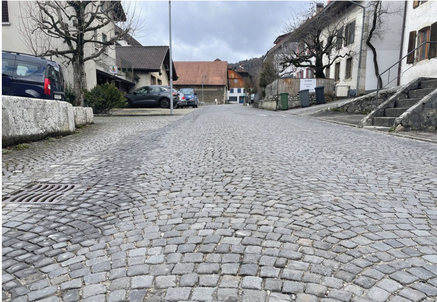
La place du village et une partie de la rue direction Frinvillier auront droit à leur lifting, cette année à Orvin.
